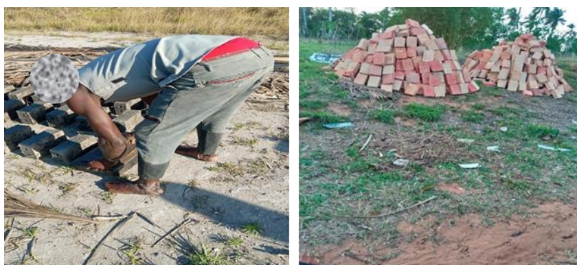
Figura 4. Processo de fabricação dos tijolos na comunidade de Cuguana.
