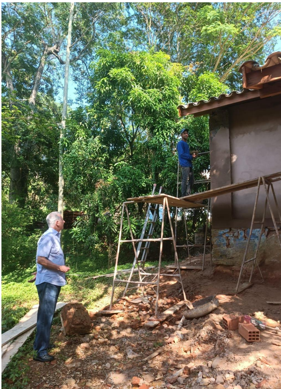
Fotografia 1. Carlos Alberto Tauil, arquiteto, durante acompanhamento técnico in loco da implantação da estrutura física do núcleo de produção de fungos da Fazenda Ambiental Fortaleza (FAF), em Mococa (SP), em 2023.
