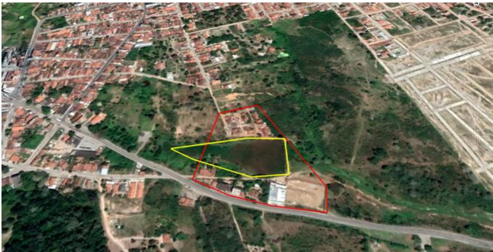
Figura 6. Área destacada em amarelo, apontando o espelho d'água do Açude do Distrito de São José da Mata. No destaque em vermelho, temos diversas ocupações residenciais irregulares e um galpão comercial construído às margens da referida APP. Fonte: Google Earth, 2019.
