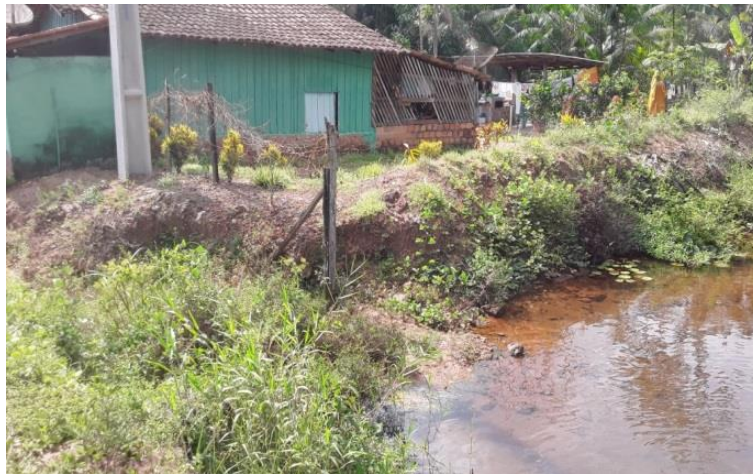
Imagem 02. Residência às margens do igarapé (nota-se a contenção de aterro). Fonte: Autor (2020).
