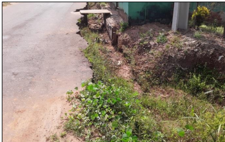
Imagem 05. Ausência de galeria em obra realizada pela Prefeitura. Fonte: Autor (2020). Fonte: Autoria própria (2020)
