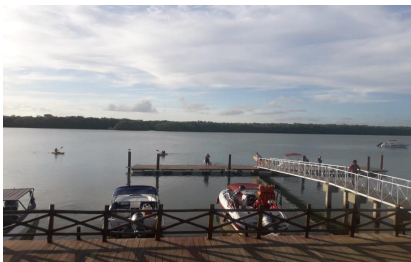
Figura 3. Atracadouro flutuante. Fonte: Autores (2020).
