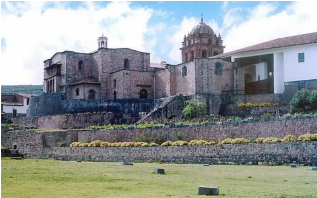
Figura 04. Construção de Cuzco (Peru) sobre as fundações das cidades incas. Fonte: HISOUR. Disponível em: < https://www.hisour.com/pt/inca-architecture-29144/ >. Acesso em 13 de dezembro de 2019.
