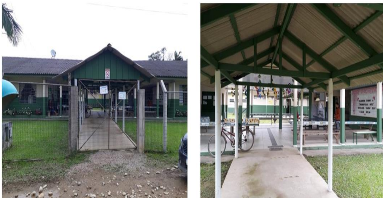
Figura 2. Vista parcial do Colégio Estadual do Campo Tagaçaba - Porto da Linha. Fonte: Os autores.
