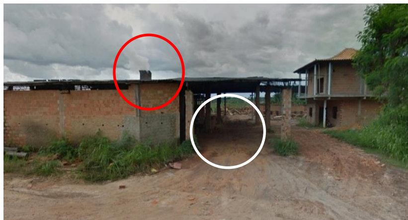
Figura 4. Emissão de fumaça e lenha dos fornos. São Miguel do Guamá, nordeste paraense. Fonte: Google Street View (2020).
