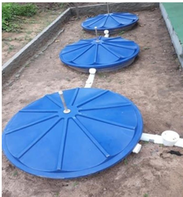
Figura 2. Ilustração da FSB utilizada no NURES/EMBRAPA, em Belém/PA. Fonte: Os autores.
