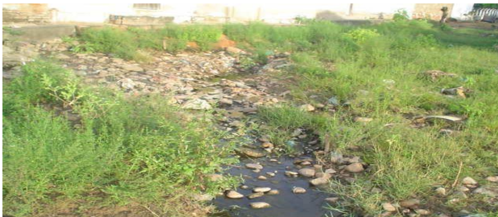
Figura 13. Um dos Esgoto de Vazantes à céu aberto. Fonte: Os autores.
