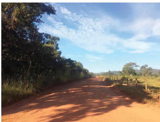
Figura 5. Pista com abaulamento inadequado. Fonte: Autores.
